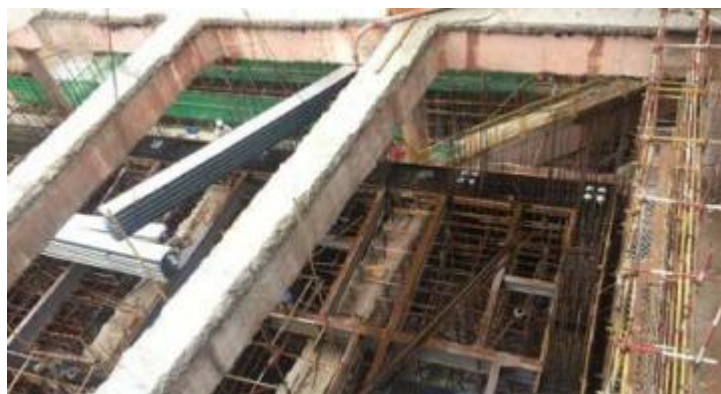
图 5.2.2-3 内支撑封板拆除后进行结构竖向先行施工
