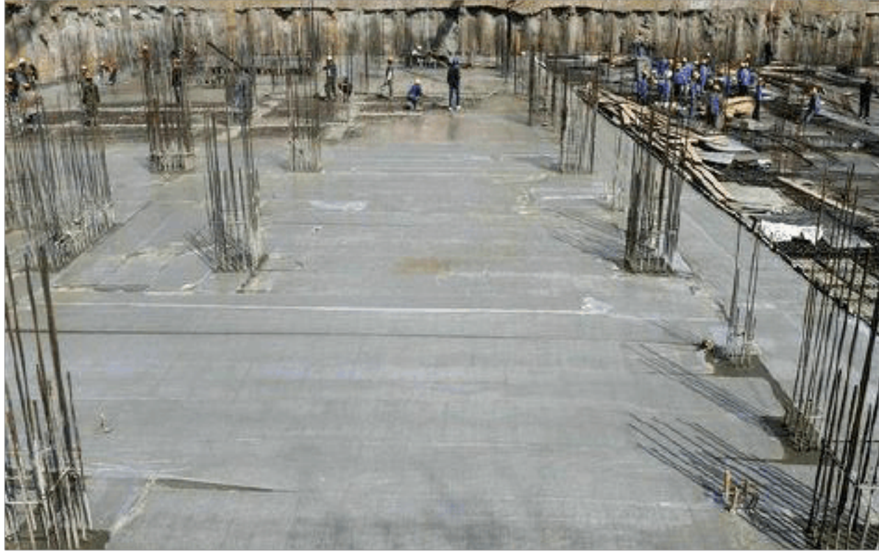
图 6-1-1 混凝土薄膜覆盖养护
