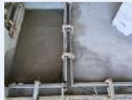
现场反坎模板拼装
