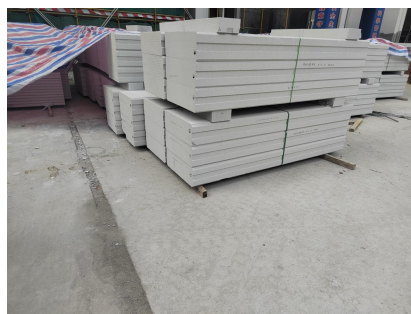
图 7.4 ALC 内墙板材料验收合格
