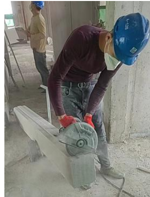
图 7.3 ALC 墙板切割
