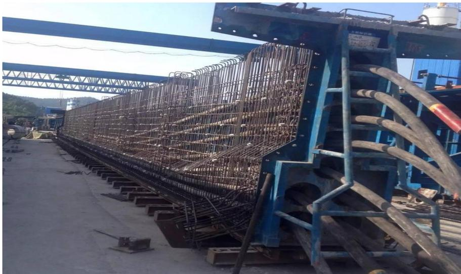
图 5. 2. 1-1 混凝土梁的制作
