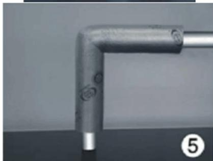
5.2 工序：将中间的圆缺反转 180 度；粘合这三部分就形成一个弯管；将弯管套在管道上；从两端向中间粘合橡塑管的开口缝，直至封合。如下图所示：
