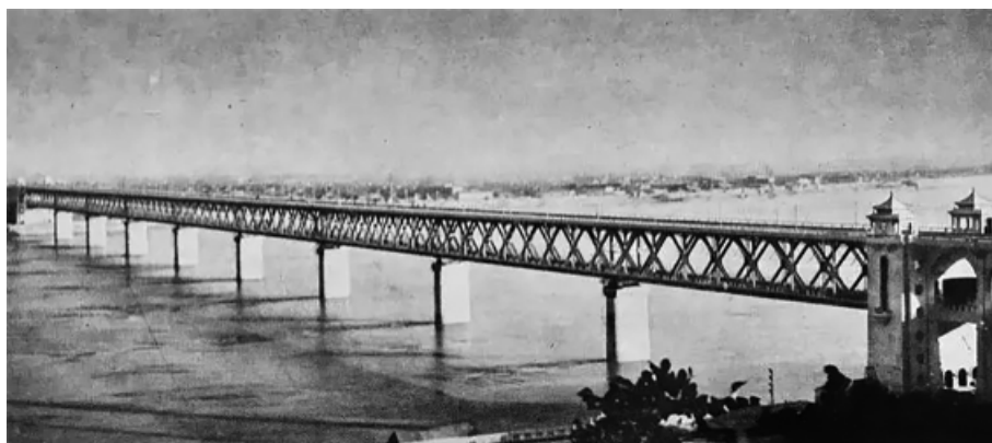
武汉长江大桥
