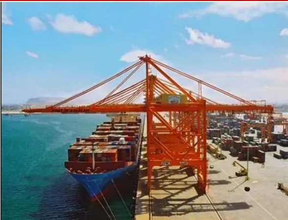
图12：振华重工：重型港口起重机（岸桥）
