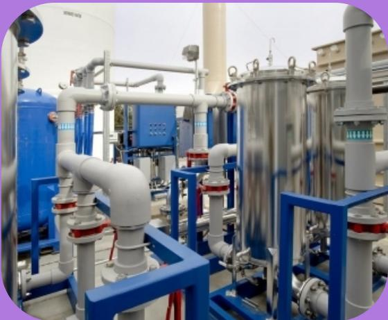
利用低温蒸汽作为加热源，通过多次蒸发和冷凝过程来淡化海水。
