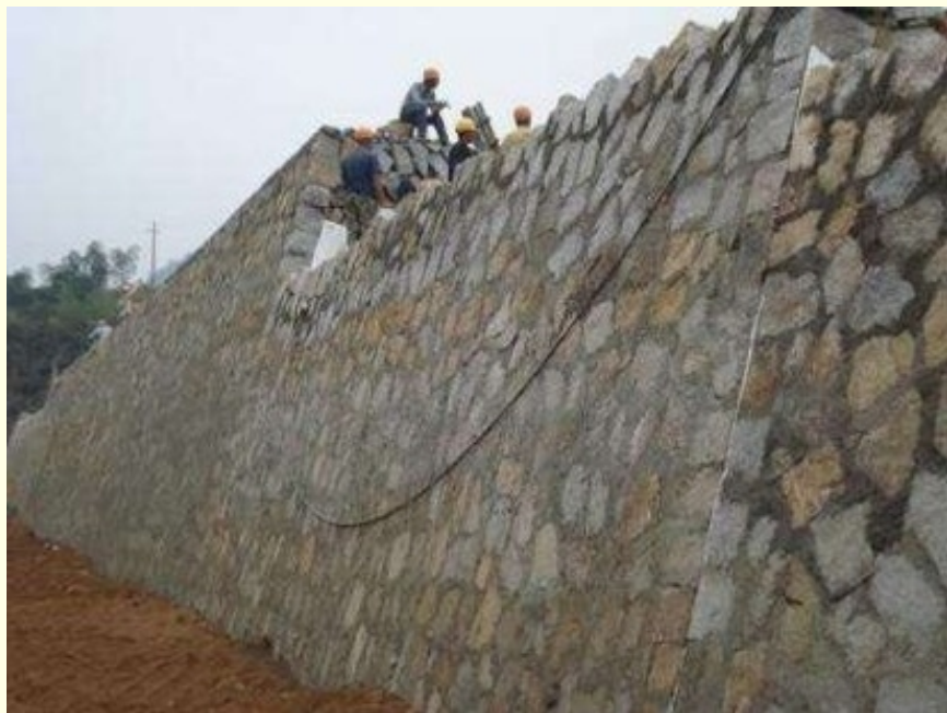
建筑工人在砌墙
