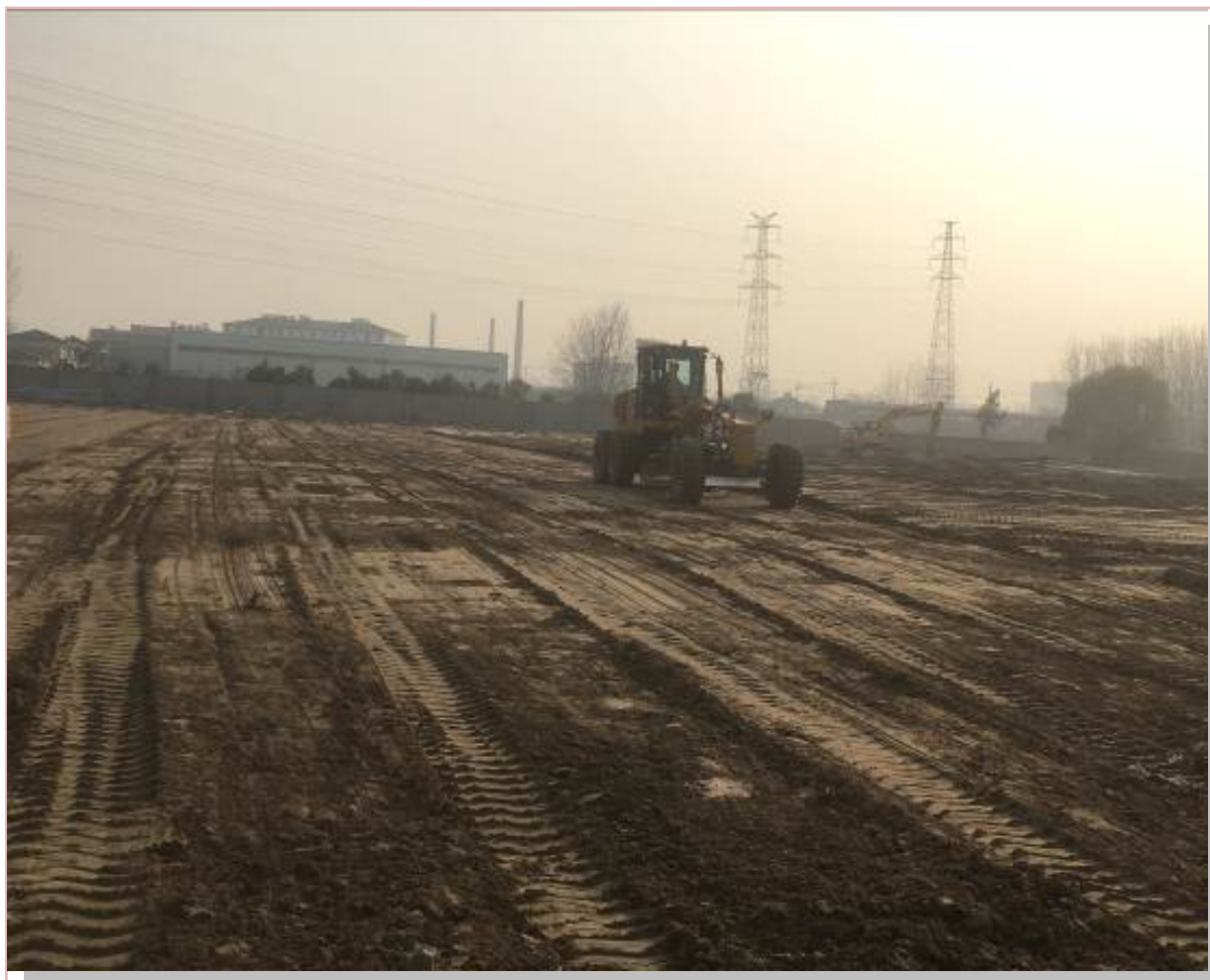
拌合站内场地平整
