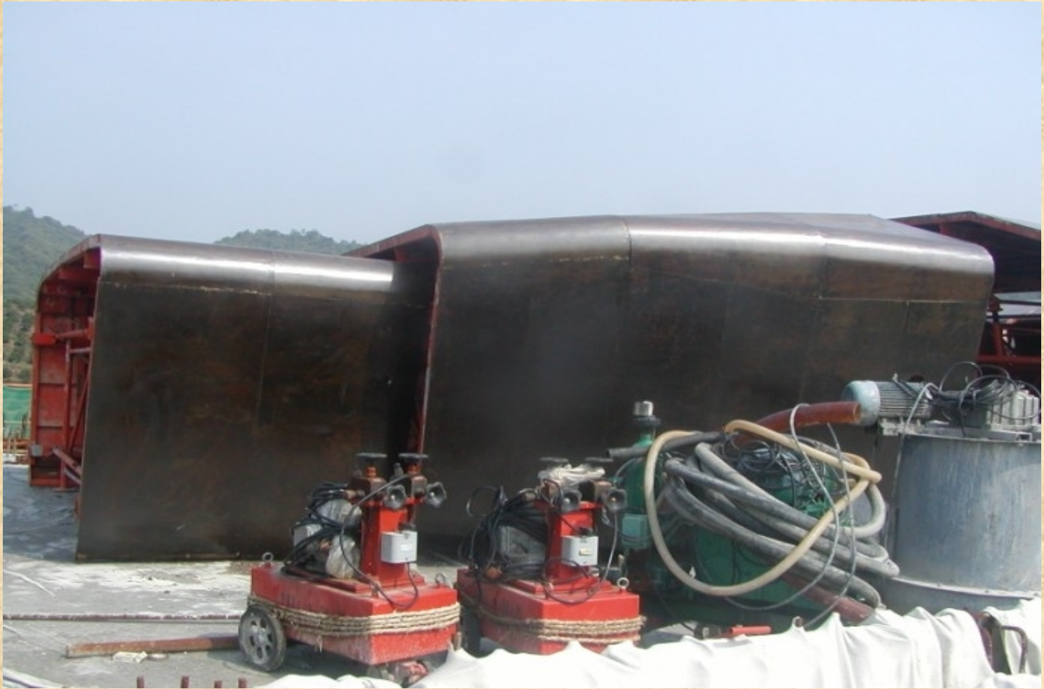
张拉压浆设备（从左依次为张拉油泵、压浆机、水泥浆搅拌机）
