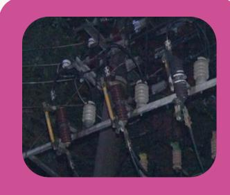
污秽物中的化学物质可能对绝缘 子材料造成腐蚀,加剧异常发热 现象。
