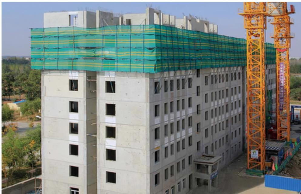
图11-3 装配整体式剪力墙结构
