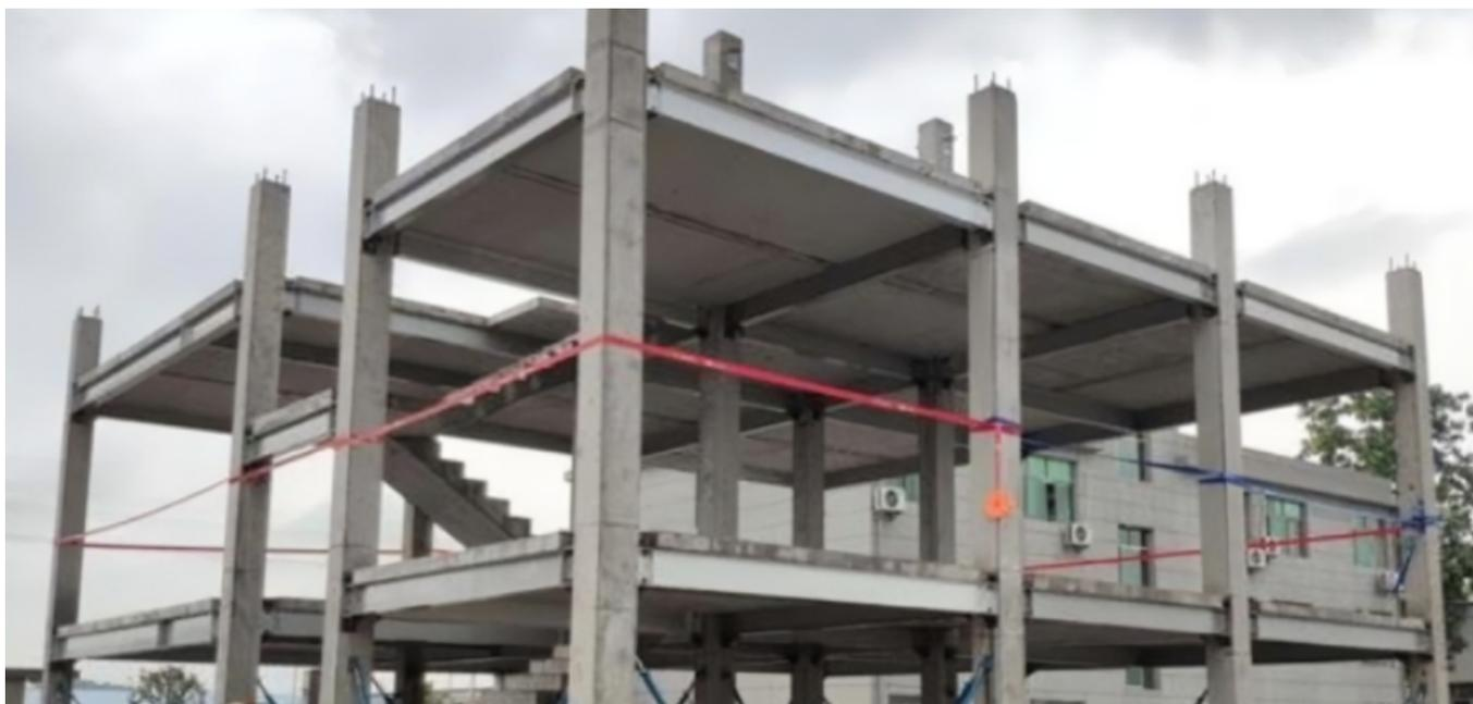
图11-1 装配整体式框架结构
