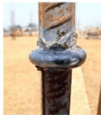
电渣压力焊
