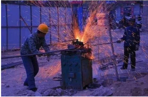
闪光对焊施工
