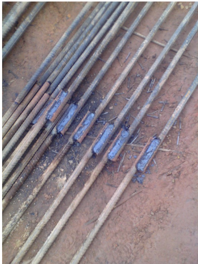
搭接焊现场图片（现场一般都做不到送检时的样子，主要还是看管理）
