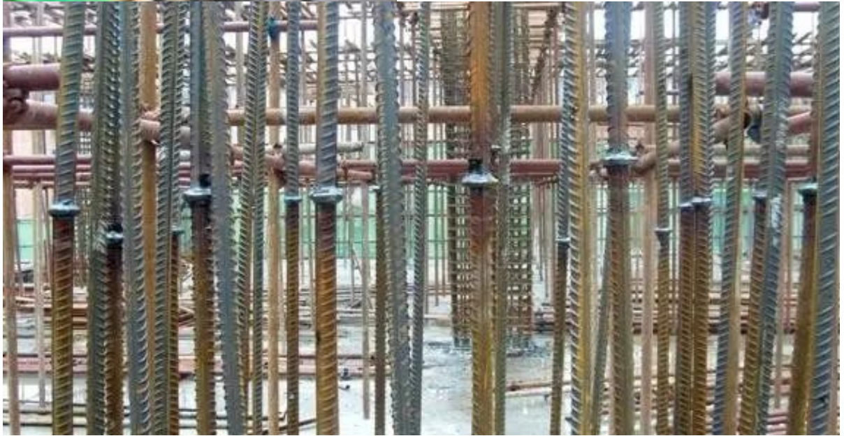
电渣压力焊成品
