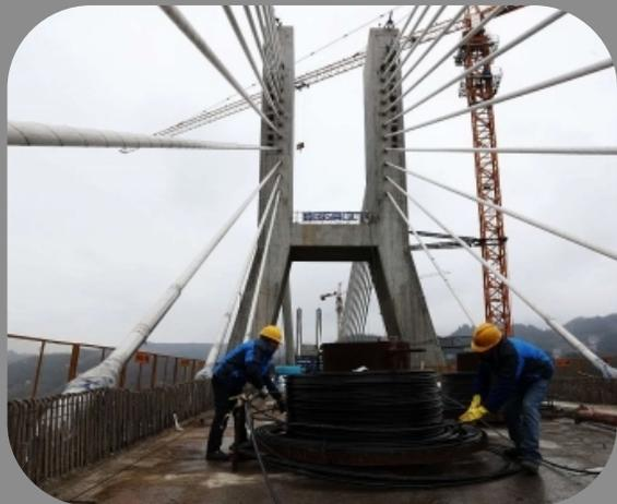
原位节段吊装施工是一种先进的桥梁施工方法，适用于大跨度斜拉桥和斜塔斜拉桥的建设。
