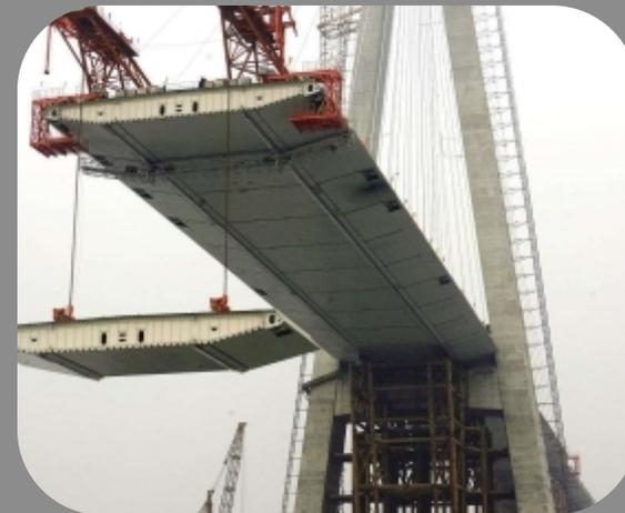
原位节段吊装施工技术具有施工周期短、质量可控、对环境影响小等优点，在现代桥梁建设中得到广泛应用。
