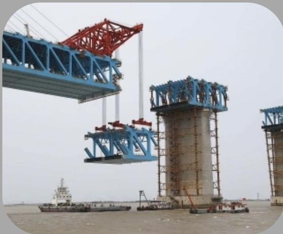
该方法采用预制节段在桥位处进行吊装拼接，通过精确的测量和定位技术，实现桥梁的高精度、高效率施工。
