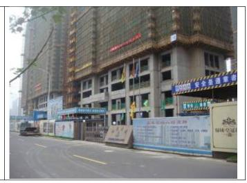
3)各施工单位应按照政府规定和甲方的 CI 规范进行现场大门的建设,大门建设方案必须报送甲方、监理批准方可开展。在工地现场四周要做围护,在临市政道路围墙上,配合甲方做 CI 宣传内容,围护高不低于 2.0 米。
