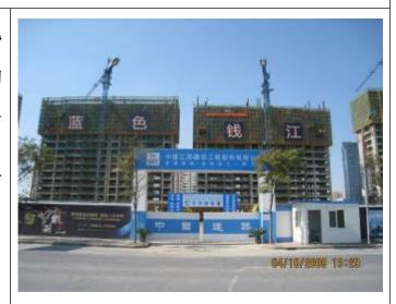
2) 大门口要进行硬化、绿地处理,出入口处要安排门卫,并设置车轮冲洗场地和冲洗龙头及
