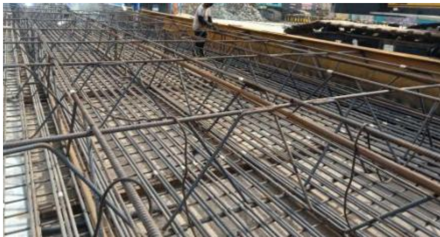
图 5.2.3-12 主钢筋笼现场制作
