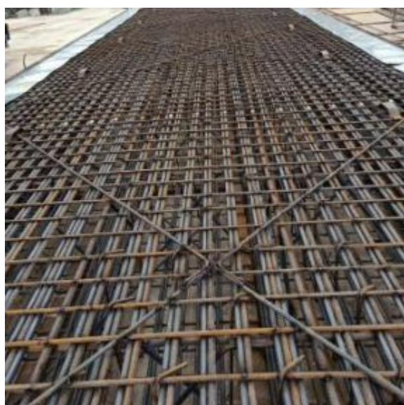
图 5.2.3-14 整体钢筋笼验收
