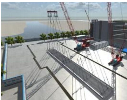
图 5.2.5-1 钢筋笼主笼试吊图
