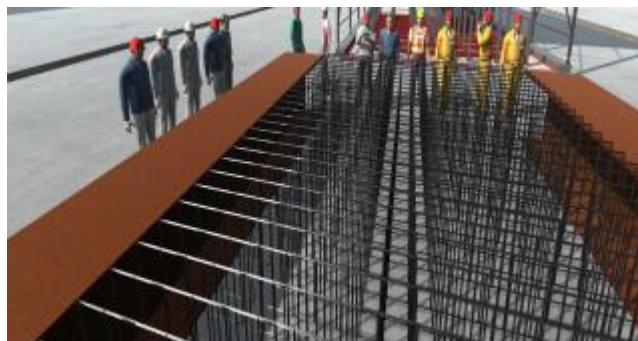
图 5.2.3-13 钢筋笼验收示意图
