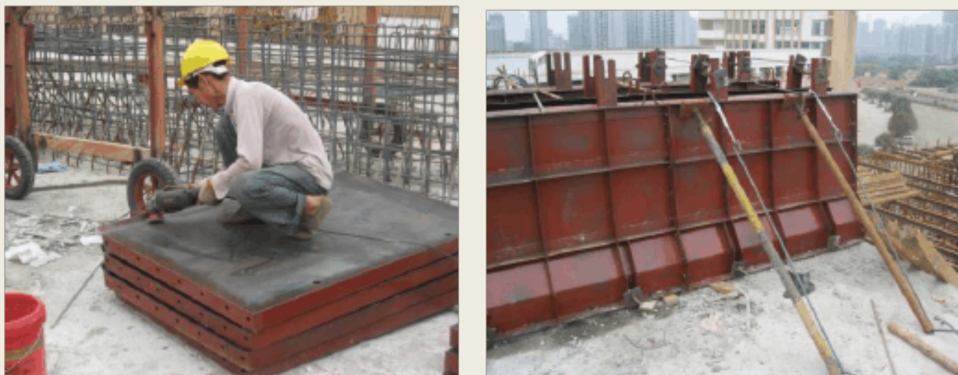
图 4.1-4 模板打磨及安装固定示意图
