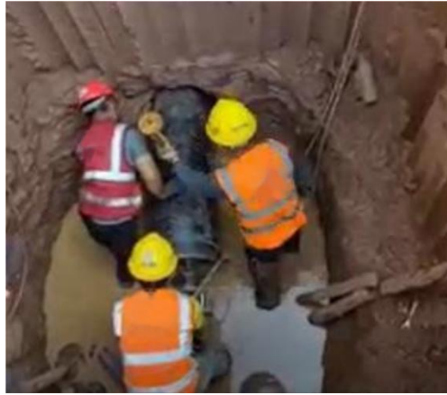
5.2.6-5 液压油缸安装
