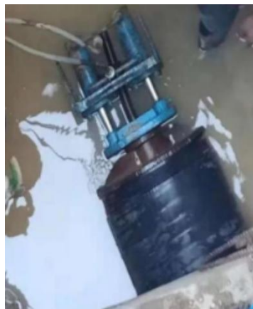
图 5.2.5-1 管道底部顶进
