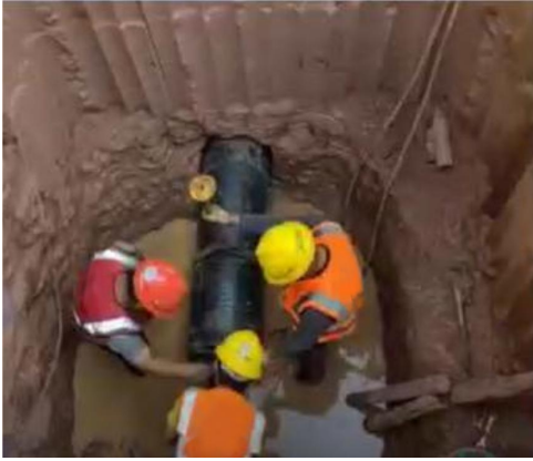
图 5.2.6-4 连接短杆安装
