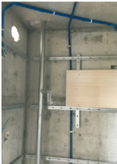
图6-7厨房墙体加固构造
