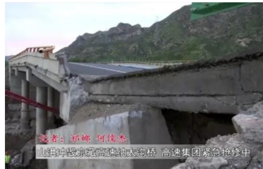
图 1.4 京藏高速纳太沟中桥
