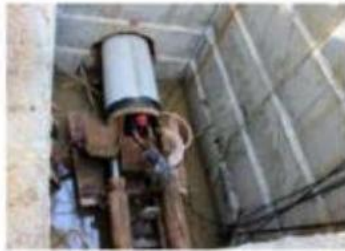
(e) 深基坑和地下管沟
