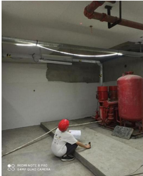
图5.2.3-1 使用红外线测距仪对基础及地面进行高度和找平度测量
