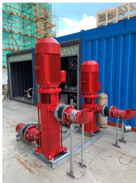
图5. 2. 5-9 模块化泵组实物图
