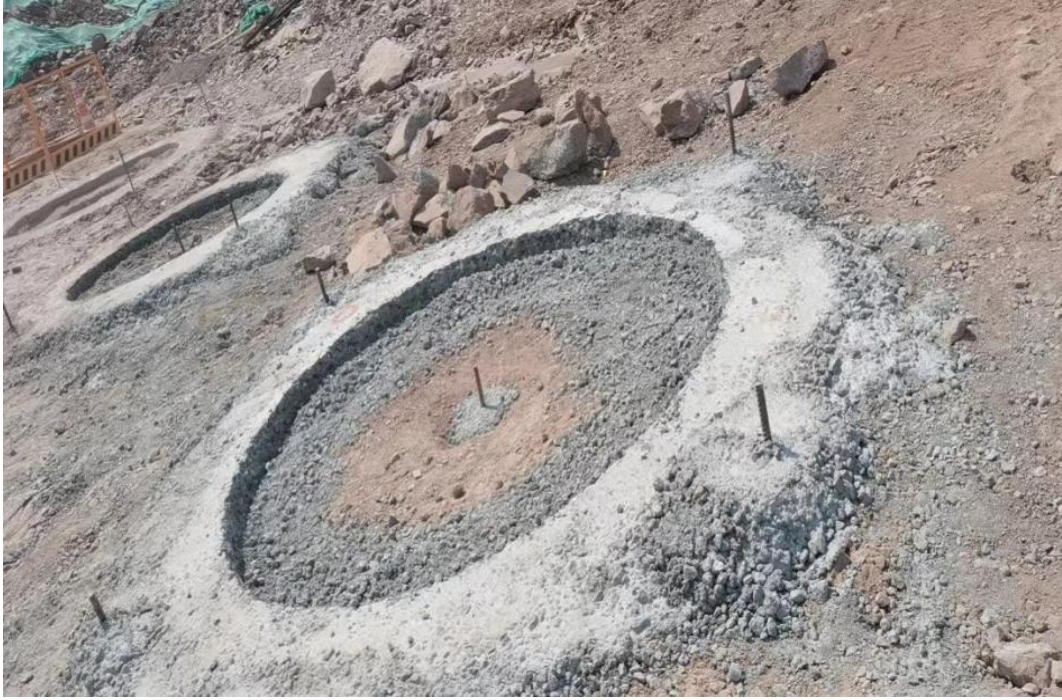
图 5.2-5 护壁加固
