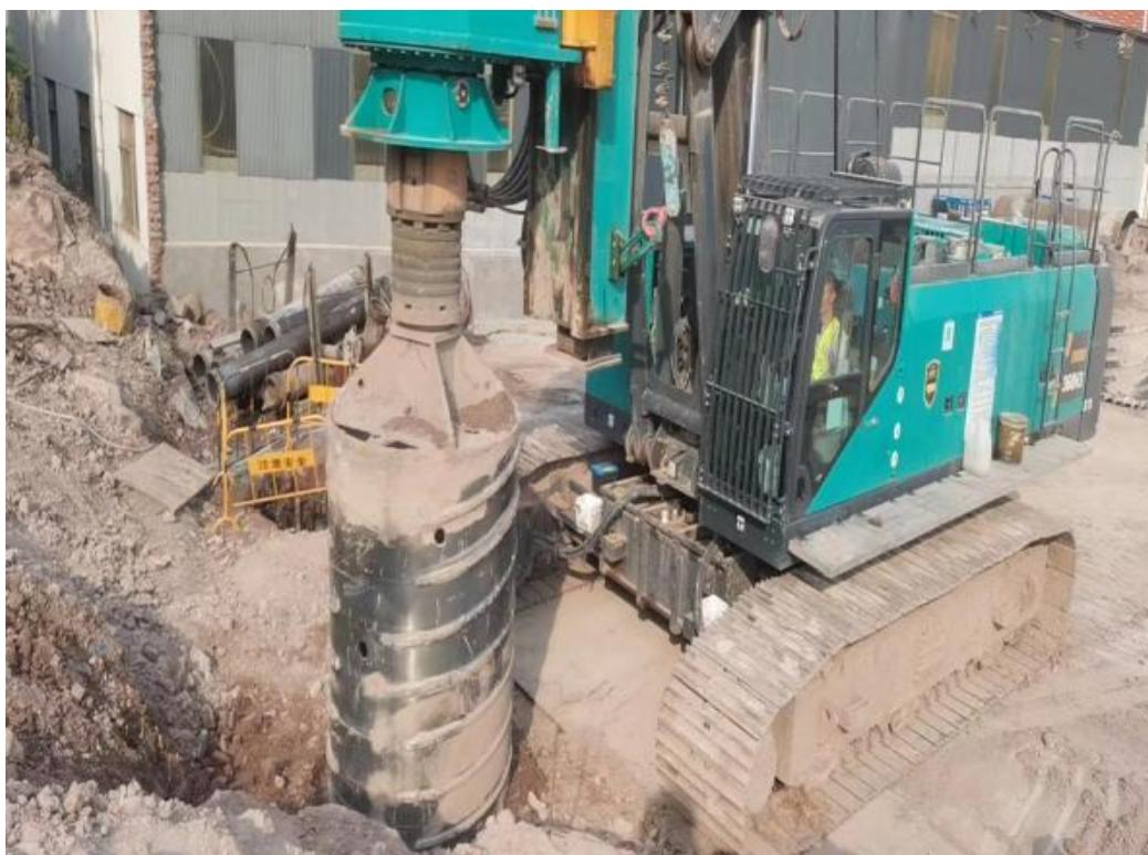
图 5.2-4 旋挖机钻孔就位
