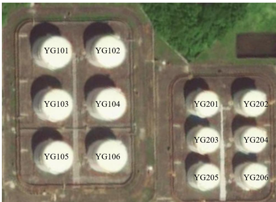
图 1 高明站主要储罐位置
