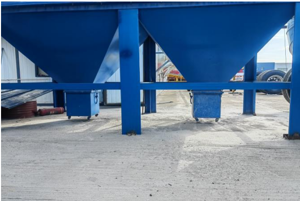
喷砂废气布袋除尘器
