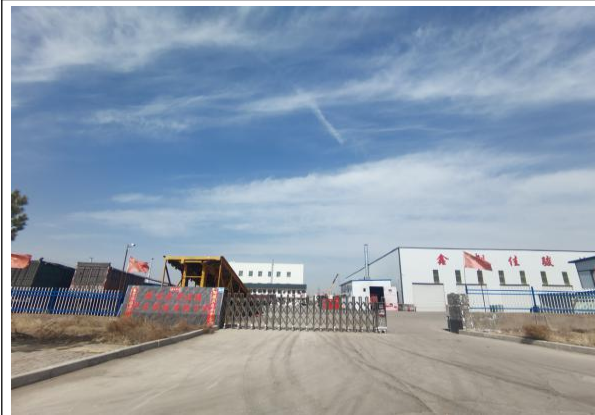
项目厂区现状
