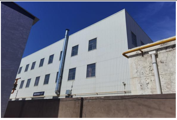
北侧凯迪拉克榆林凯瑞 4S 店汽车维修车间厂房
