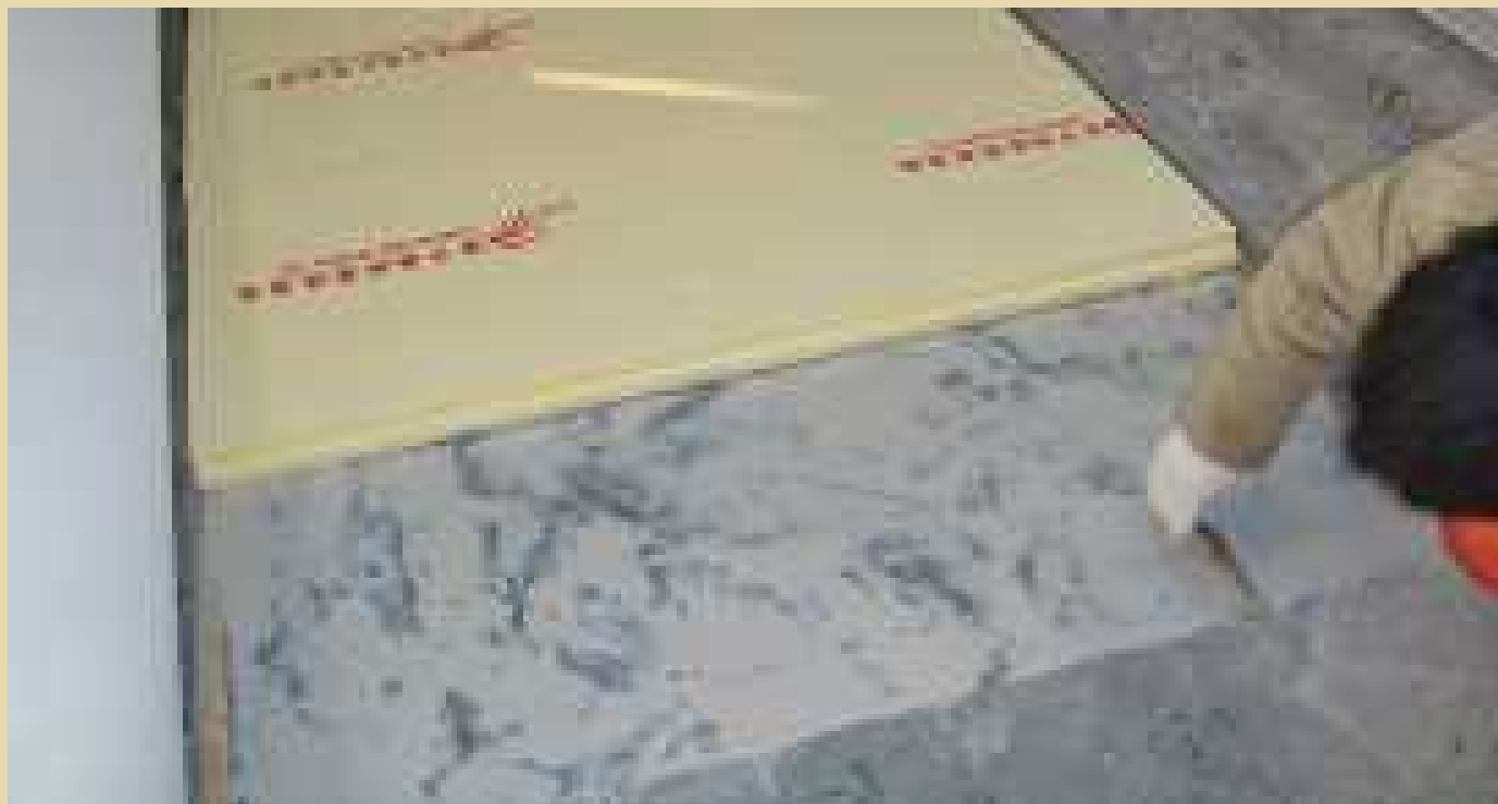
图2高强度挤塑板的横向拼接
