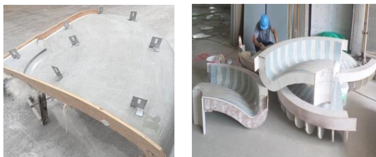
(d) 吊挂点位设置 (e) GRG半成品缺陷修补
