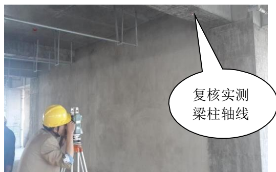
图5.2.2 吊顶区的施工现场测量复核
