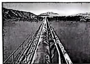
图 3 西气东输跨黄工程
