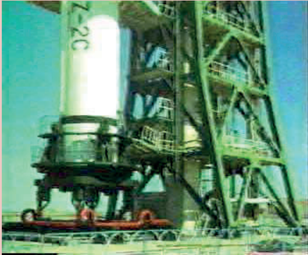
火箭发射架中的压杆
