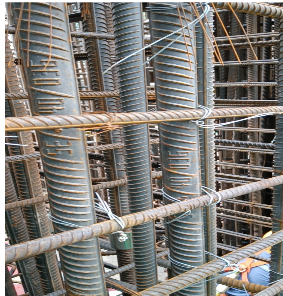
现场高强钢筋使用
