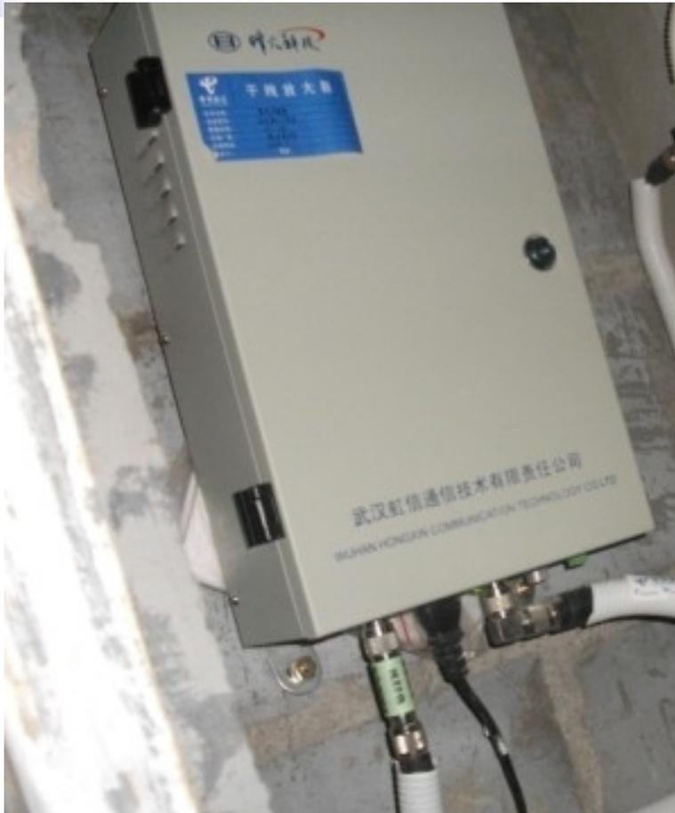
干线放大器安装，要求安装在室内，远离强电、强磁、强腐蚀场所。环境清洁、干燥，温度适宜的场所，固定牢固，做可靠接地。
