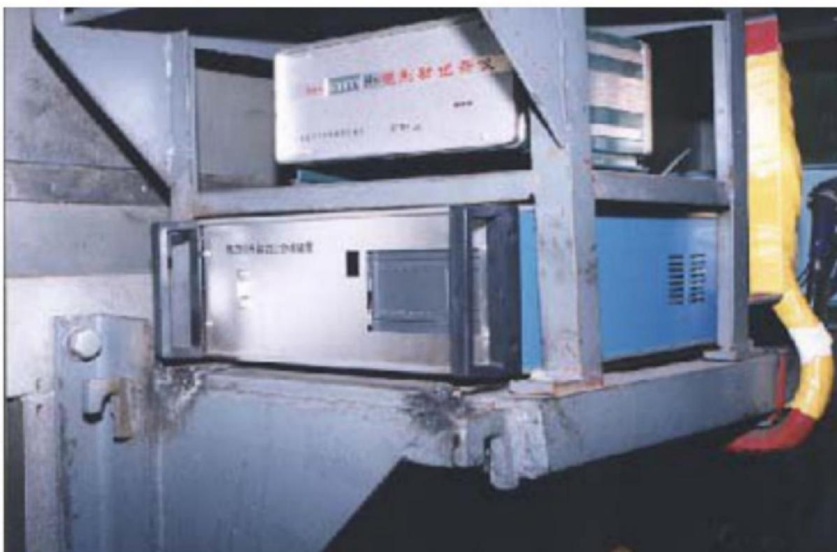
图 2 自动过分相控制装置安装图
