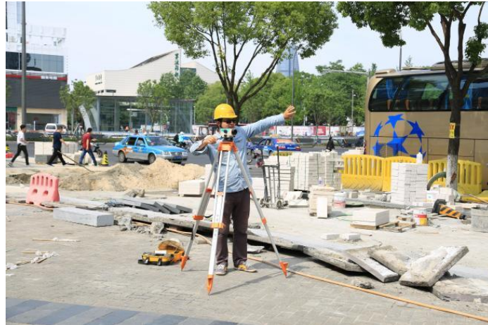
图 5.2.8 现场测量放线
