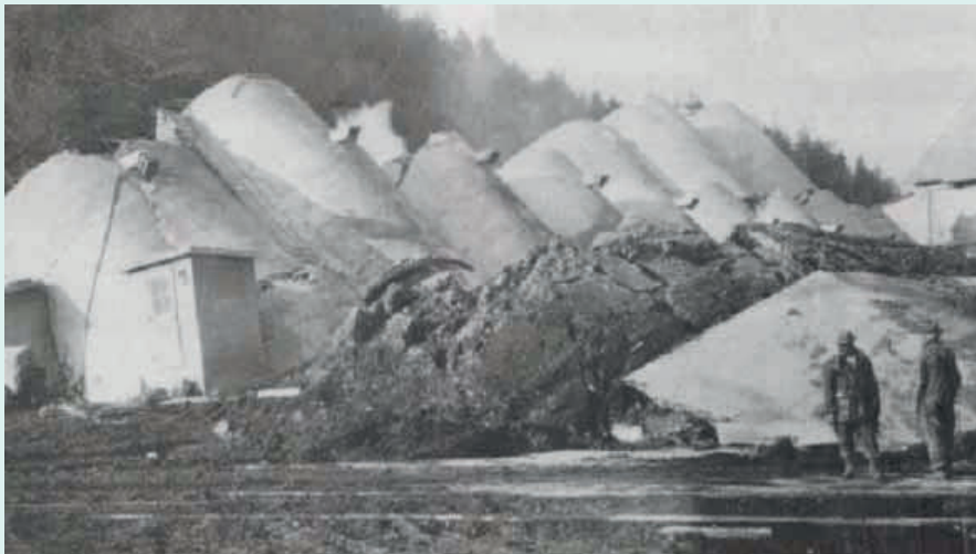
在粘土地基上的某谷仓地基破坏情况
