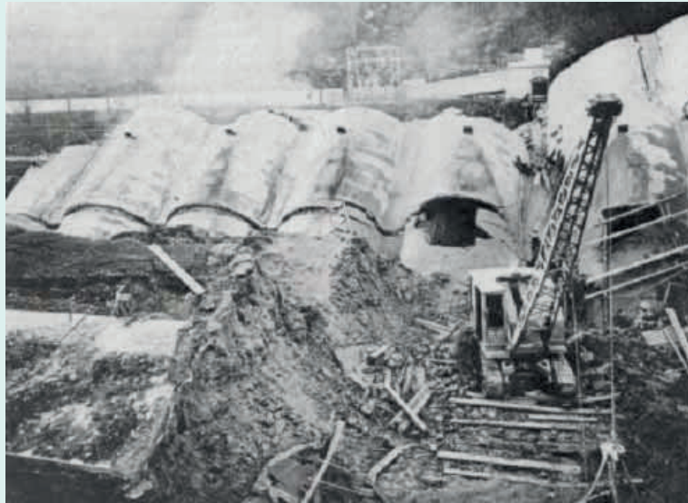
194年在软粘土地基上的某水泥仓的倾覆
