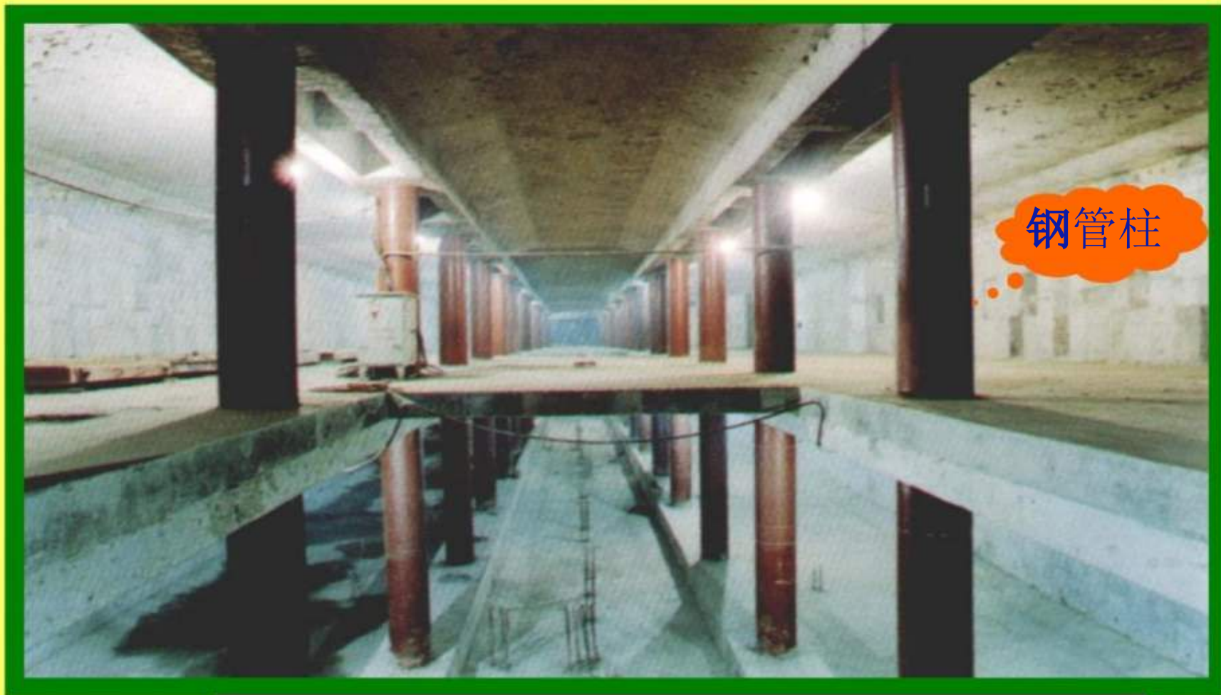
北京地铁复八线永安里站(盖挖)
