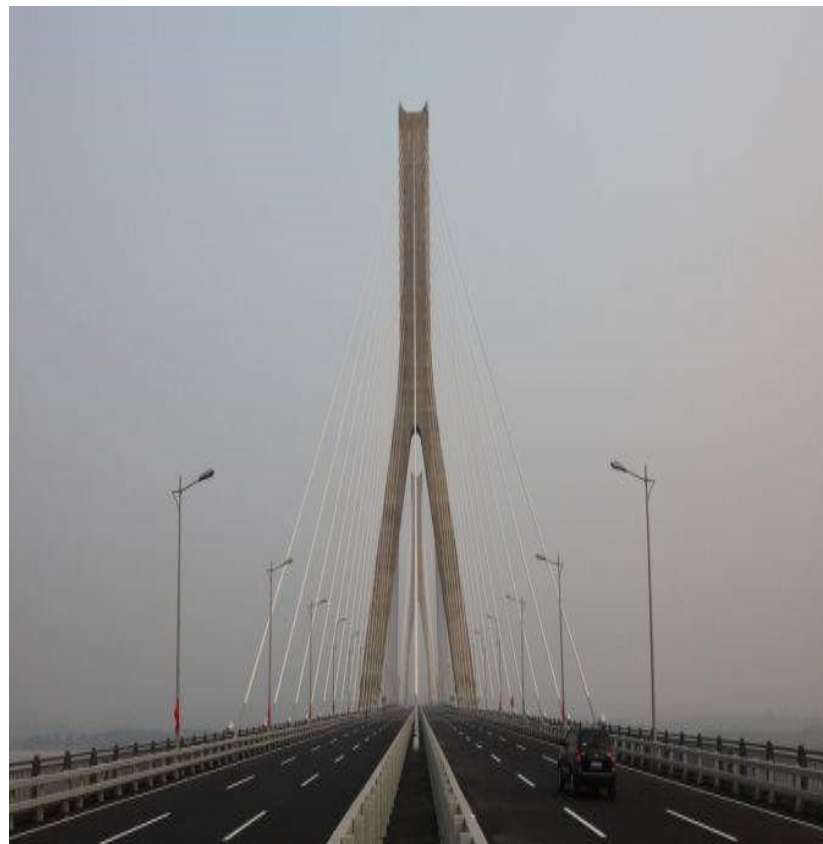
武汉天兴洲大桥
