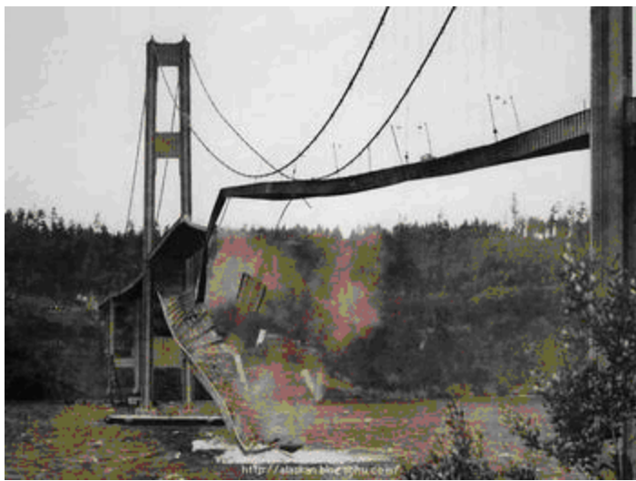
图10.8 塔科马桥的扭转振动图
