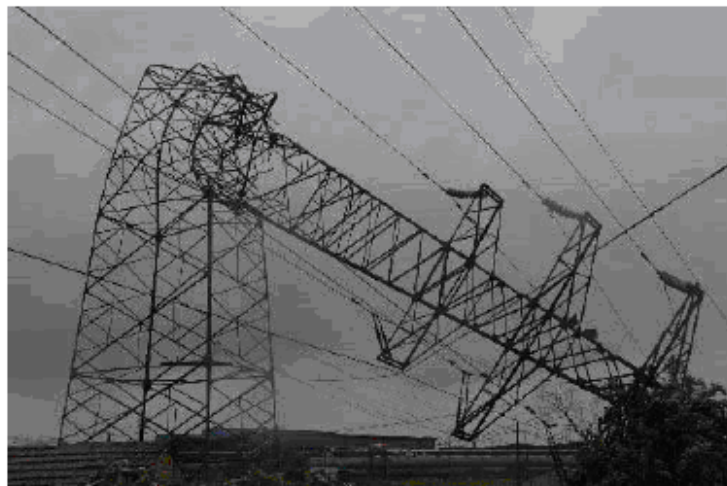
图10.13 被台风“麦莎”拦腰折断的高压输电塔
