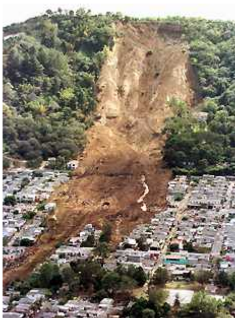
图10.6 地震引发的泥石流
