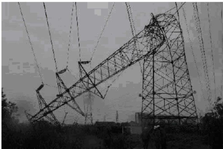
图10.13 被台风“麦莎”拦腰折断的高压输电塔
