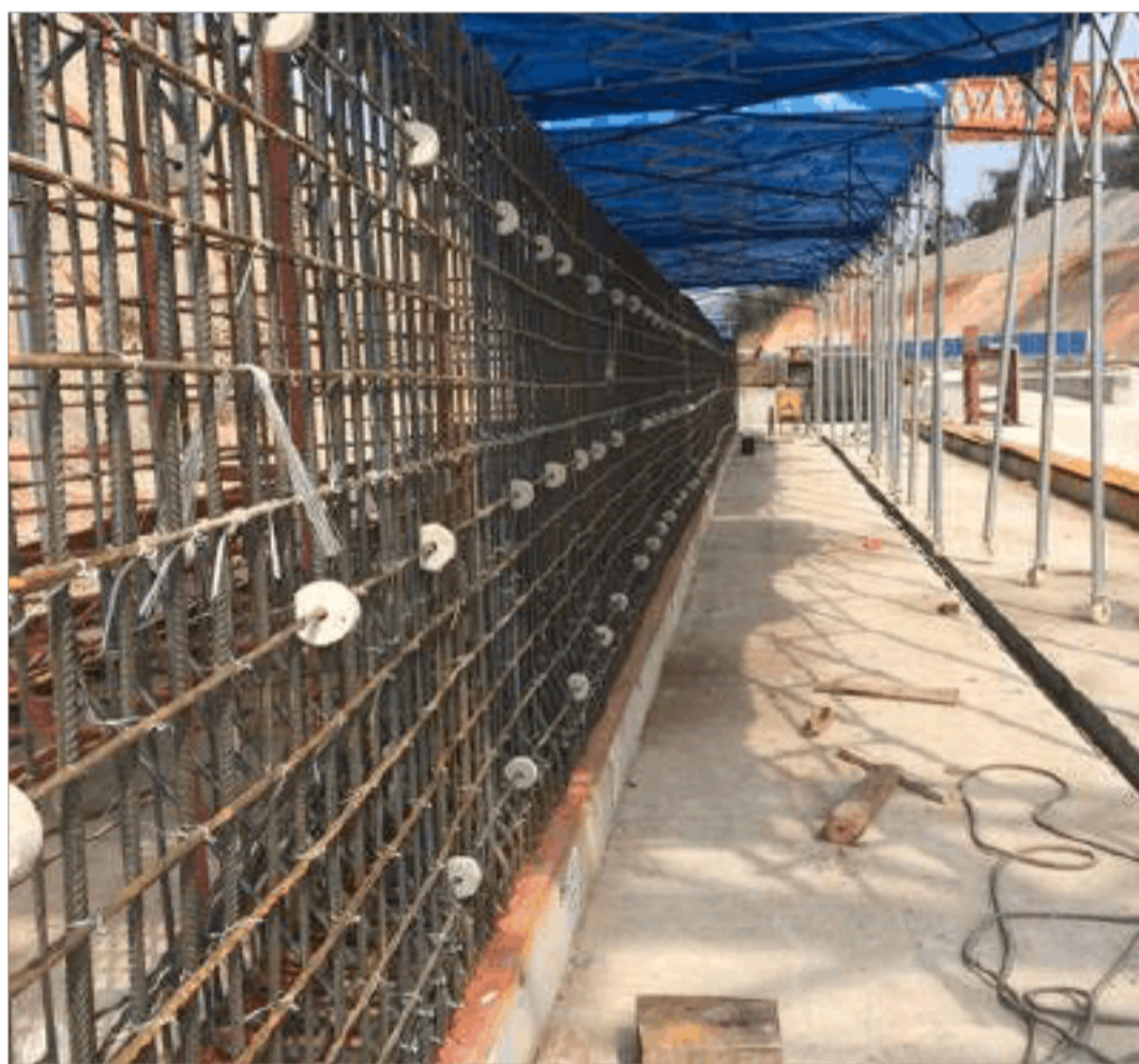
T梁钢筋在台模上绑扎
