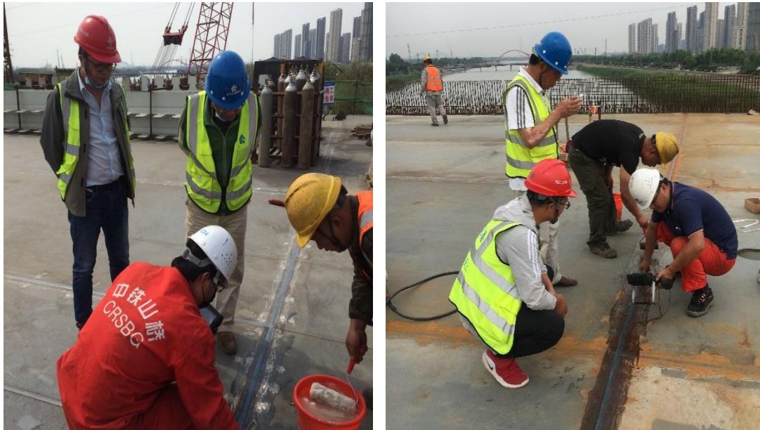
钢箱梁焊缝质量现场检测采集数据
