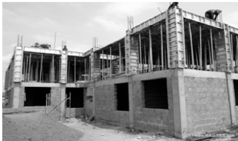
(b) 现场浇筑(柱梁)现场砌筑(墙体)
