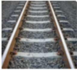
B. 铁轨铺在枕木上
