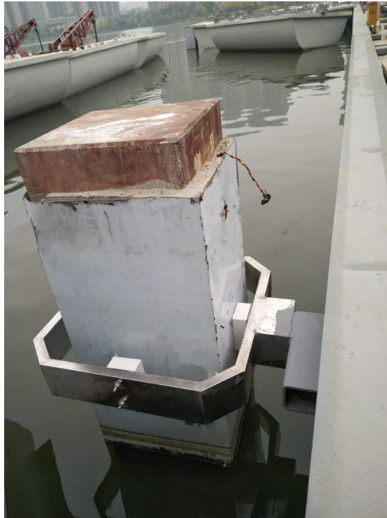
图 5.2.1.2-3 定位桩安装效果图
