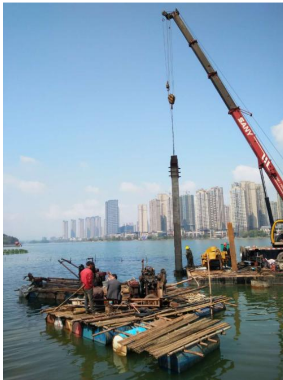
图 5.2.1.2-2 定位桩安装
