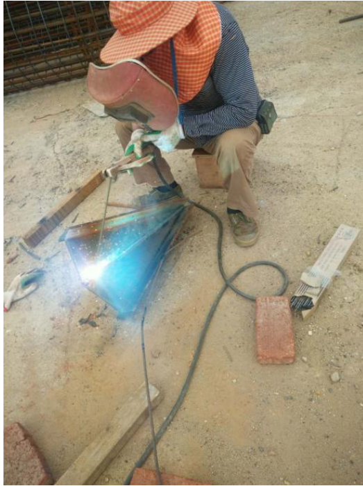
图 5.2.1.1-1 定位桩头制作
