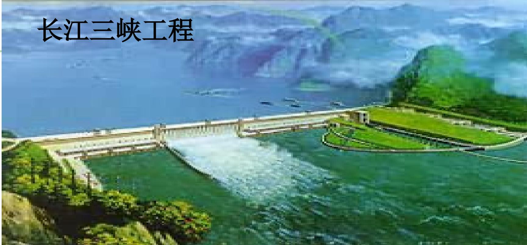
三峡水库总库容393亿立方米，总装机容量1820万千瓦，是世界上最大的水电站。
