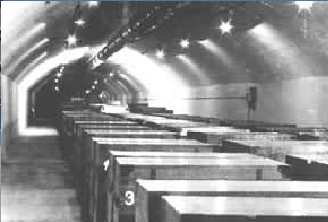
辽宁省档案馆的洞库
