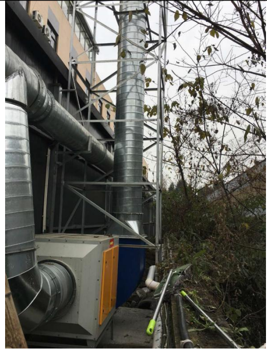
生产车间（二）净化器+排气筒
