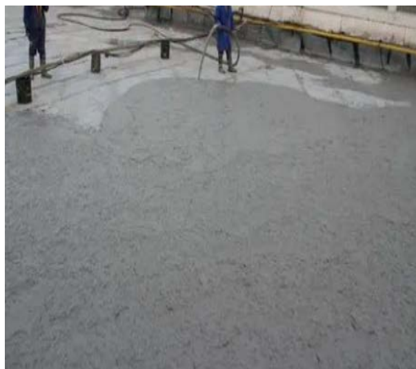
图5-6 泡沫混凝土第一层找坡施工
