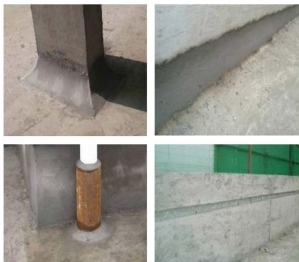
图5-3 泛水处理和女儿墙预留凹槽
