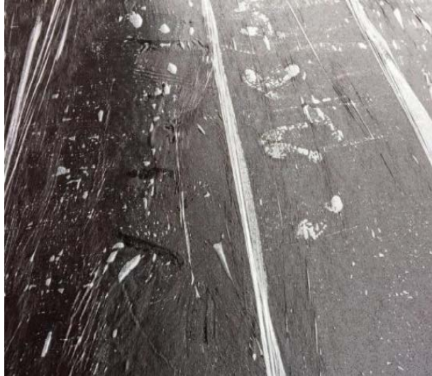
图5-5 第三遍涂刷及防水薄膜
