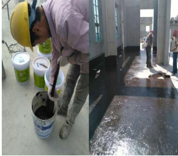
图5-4 材料准备、第一遍涂刷
