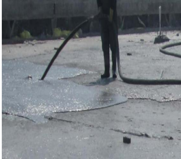
图5-6 泡沫混凝土第二层找坡施工
