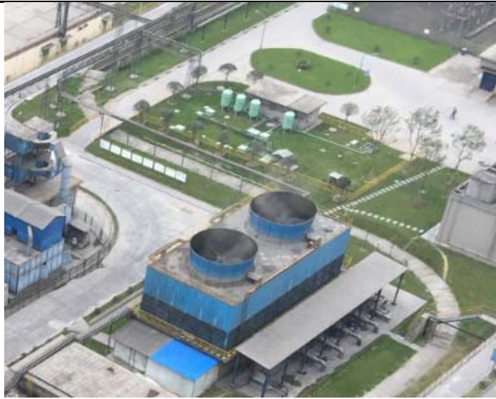
图2-7 拉法基水泥厂区内废水处理设备
