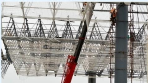
大跨度箱形桁架结构通常采用高强度钢材构成，具有良好的承载能力和稳定性。
